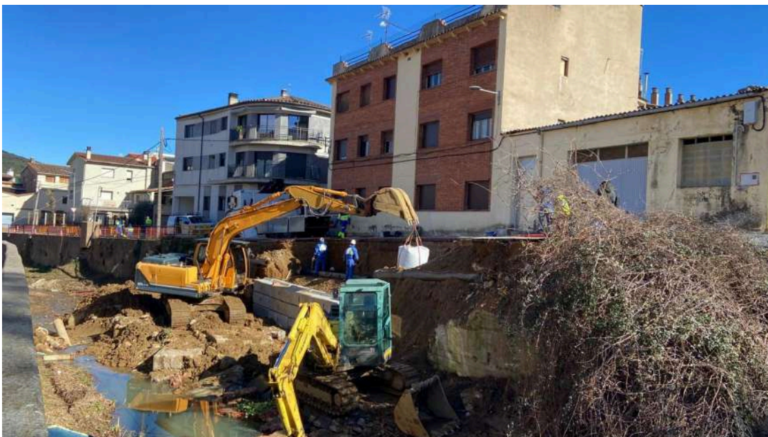
Varios operarios trabajan para reponer la tubería derrumbada en Anglès
