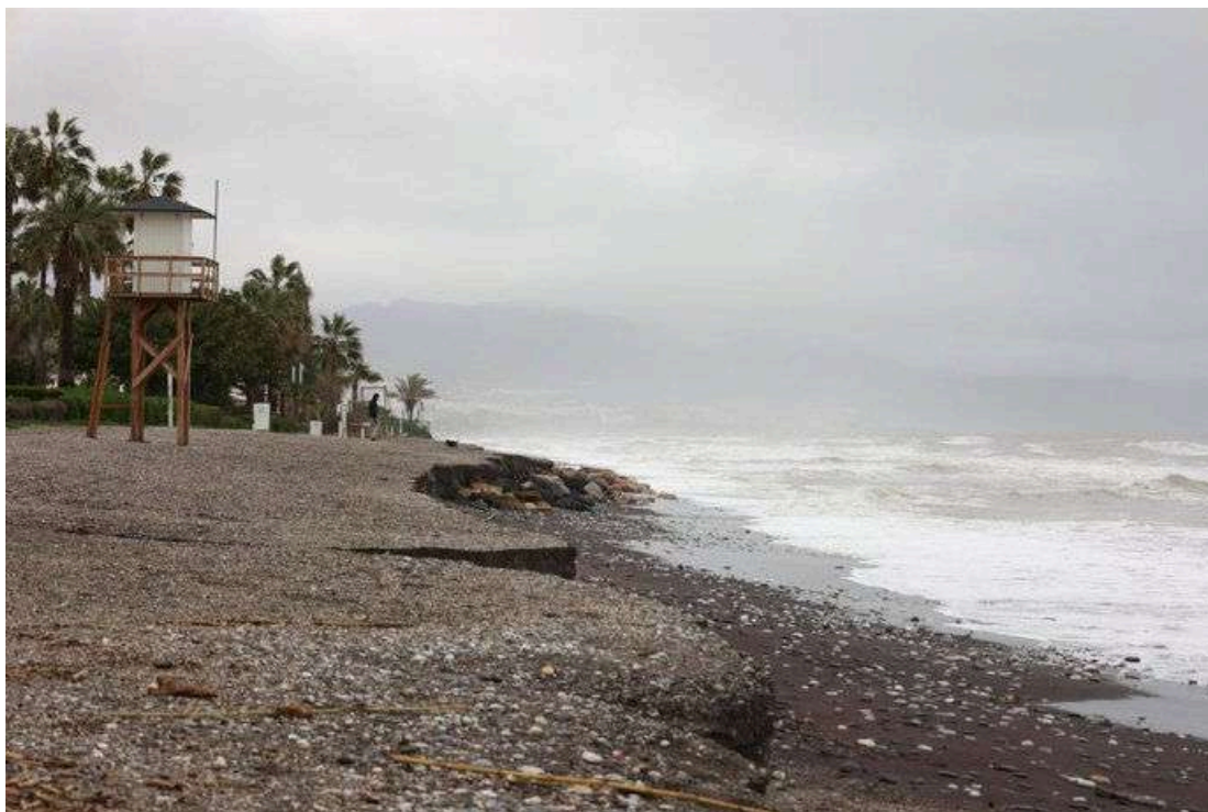
Daños del temporal en Torrox - AYUNTAMIENTO DE TORROX
